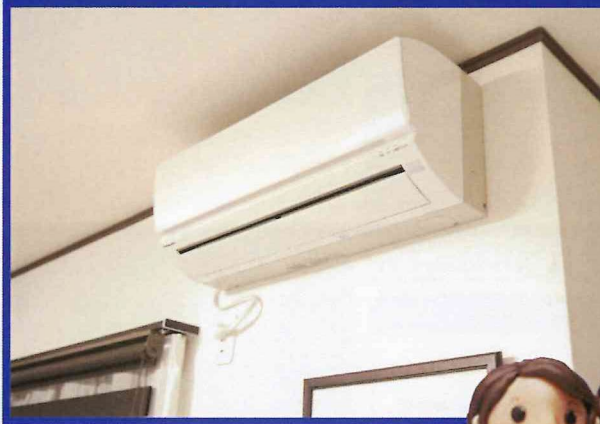
エアコン取付
