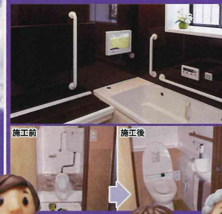
手すり取付 高齢者向けリフォーム
